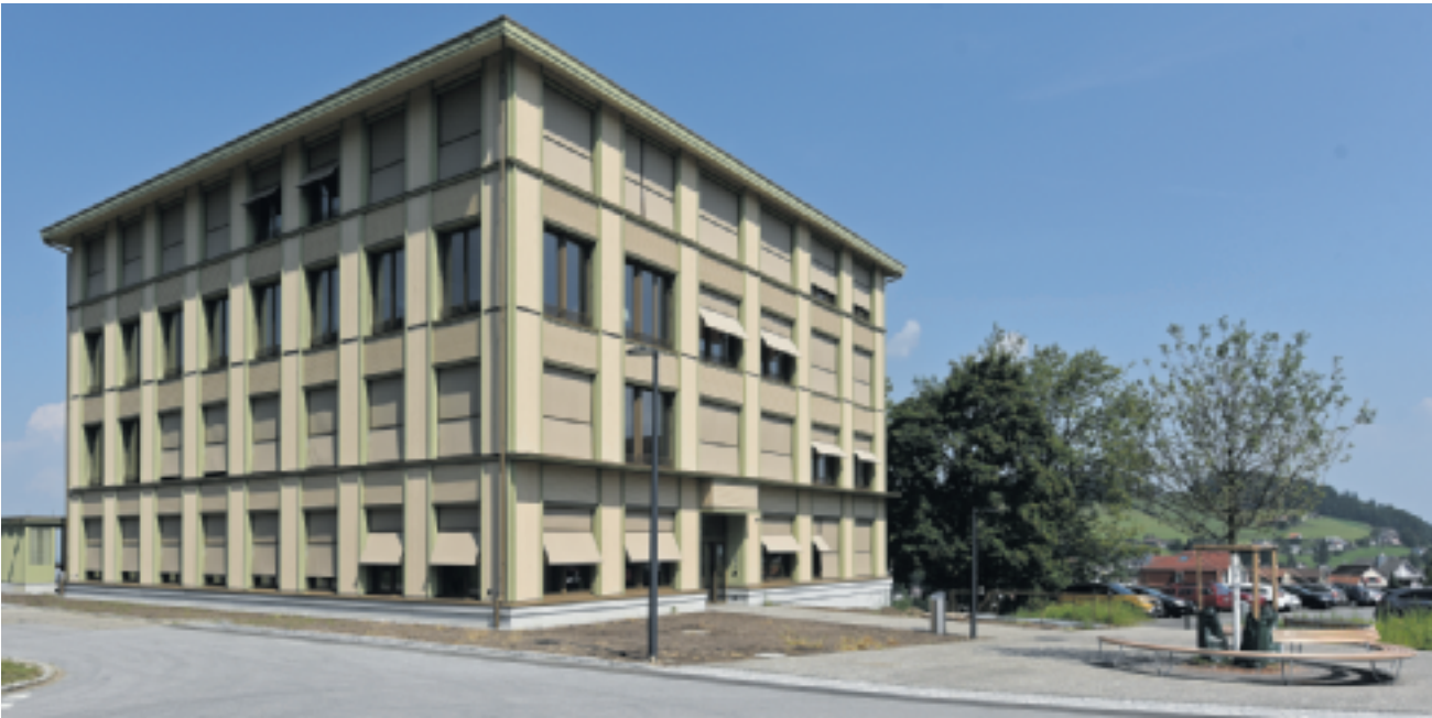
Das neue Besucher- und Therapiezentrum in Herisau ist nach zweieinhalb Jahren Bauzeit nun bezugsfertig.
