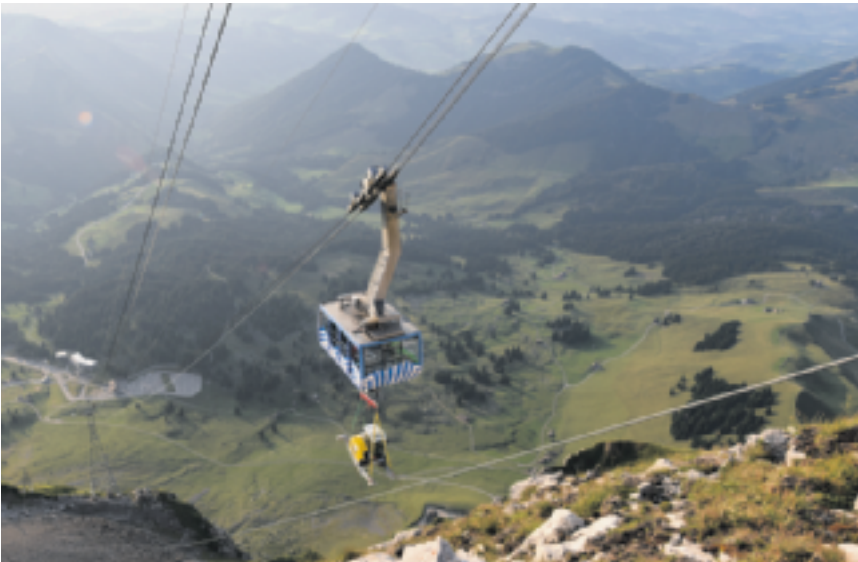
Nachdem ab Mittag die Monteure Silvan Seitz und Marco Matt den «Muck» von den Rädern und dem Arm befreiten, ging es für den nur noch etwa 5 Tonnen schweren Schreitbagger um 19 Uhr talwärts.
