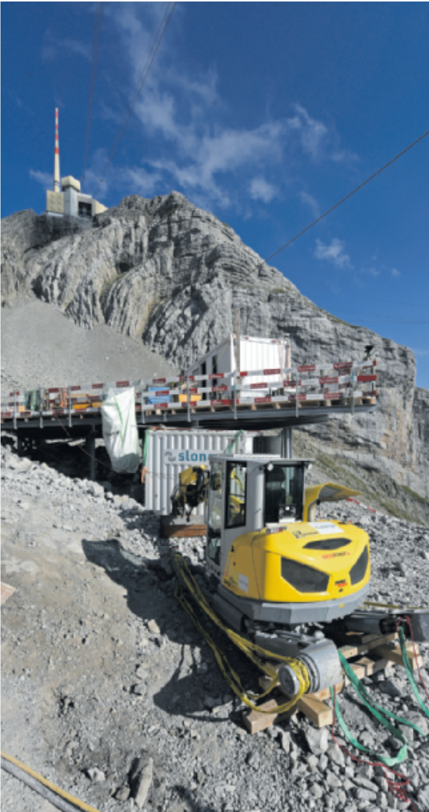
Seit dem 1. Mai war der von Maschinist Martin Zellweger bediente Bagger auf der 2256 Meter über Meer gelegenen Baustelle während ungefähr 275 Betriebsstunden rund um die Stütze 2 im Einsatz.
