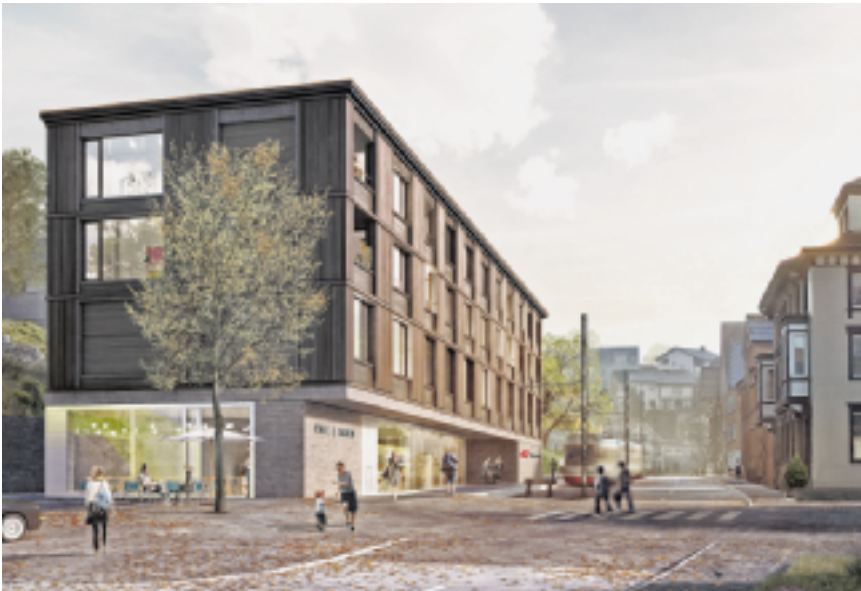
ebenfalls in gleicher Architektur ausgeführt werden soll. Es ist vorgesehen, das Projekt mit dem Fahrplanwechsel im Herbst 2027 der Öffentlichkeit zu übergeben. Wäre es nach dem Willen der Appenzeller Bahnen gegangen, wäre der Bahnhof in Trogen (rechts) schon seit Jahren durch einen Neubau ersetzt worden, wie die Visualisierung aus dem Jahr 2017 zeigt. (Visualisierungen: carlos martinez architekten / bernardo bader architekten)
