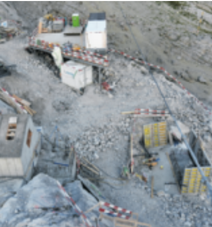
Die Plattform befindet sich direkt unter der Seilbahn. Rechts entsteht das vierte Fundament.
