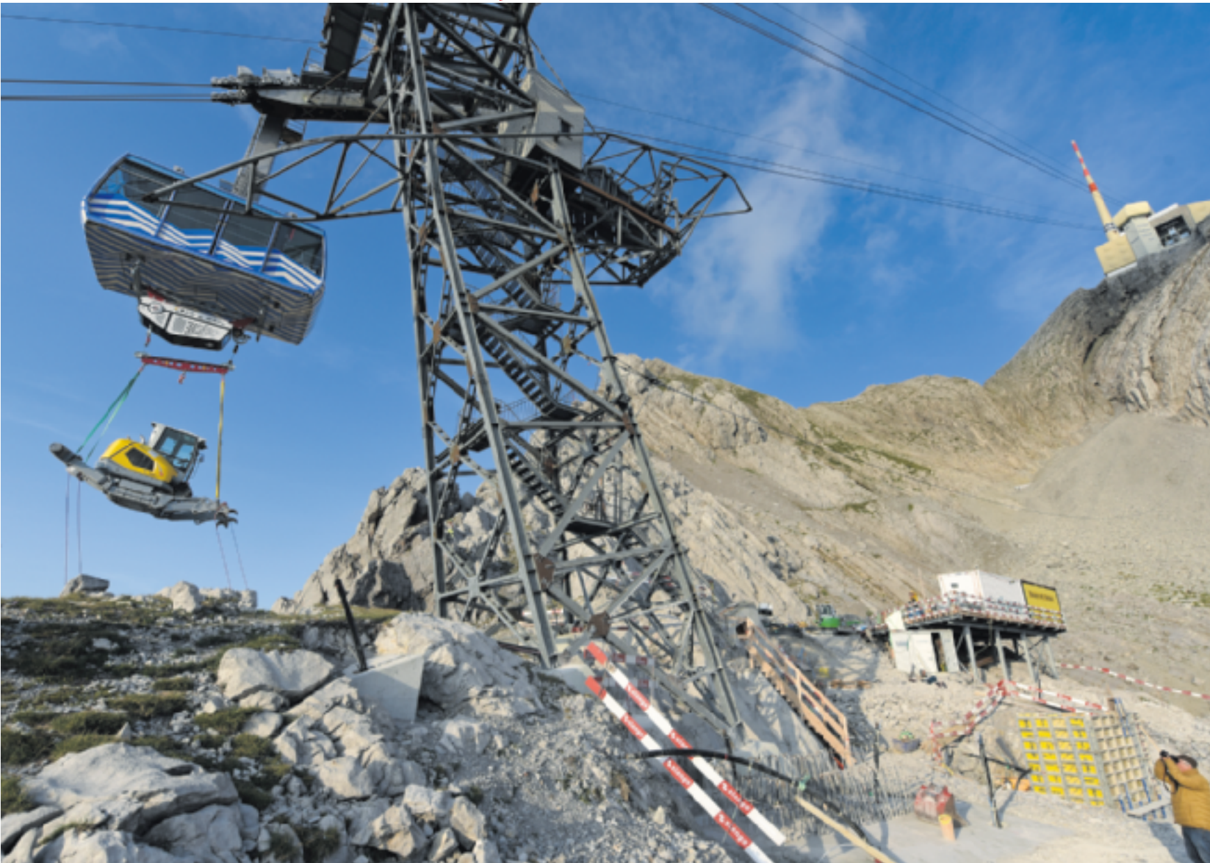
Rund 450 Höhenmeter unterhalb der Säntisbahn-Bergstation laufen seit Frühling die Bauarbeiten für vier Fundamente einer neuen Stütze. Weil nun der «Muck» nicht mehr benötigt wird, wurde er ins Tal gefahren. Seite 10 (Bild: Hans Ulrich Gantenbein)
