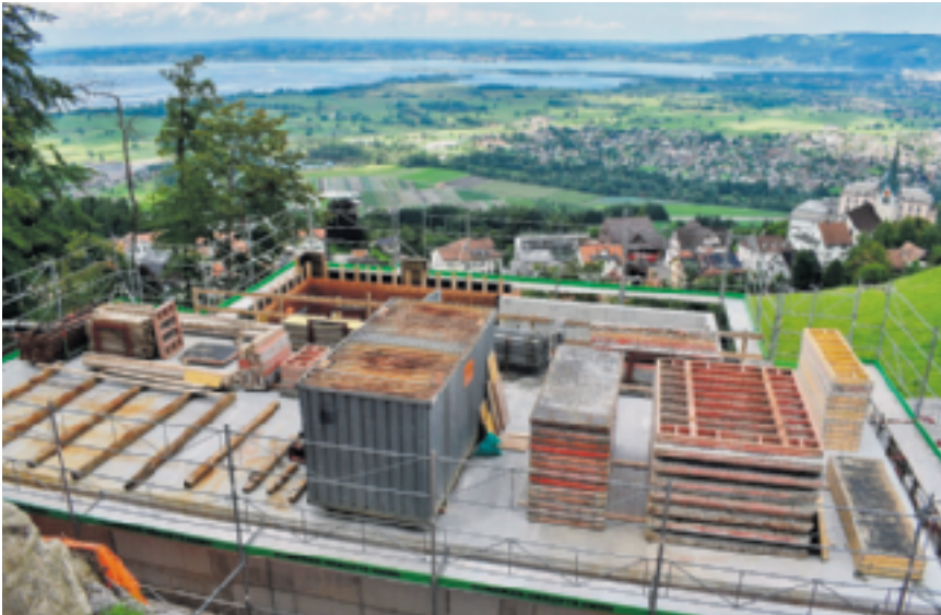
Die beiden Wasserkammern mit dem vorgesetzten Rohrkeller.
