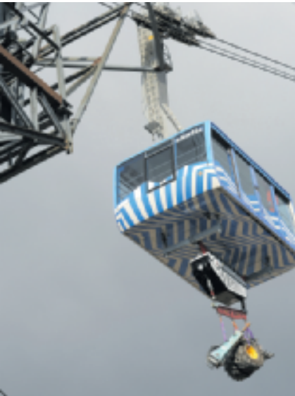
Zuerst «flogen» die Räder, die Baggerschaufel und der Hydraulikhammer ins Tal. (Bilder: H9)
