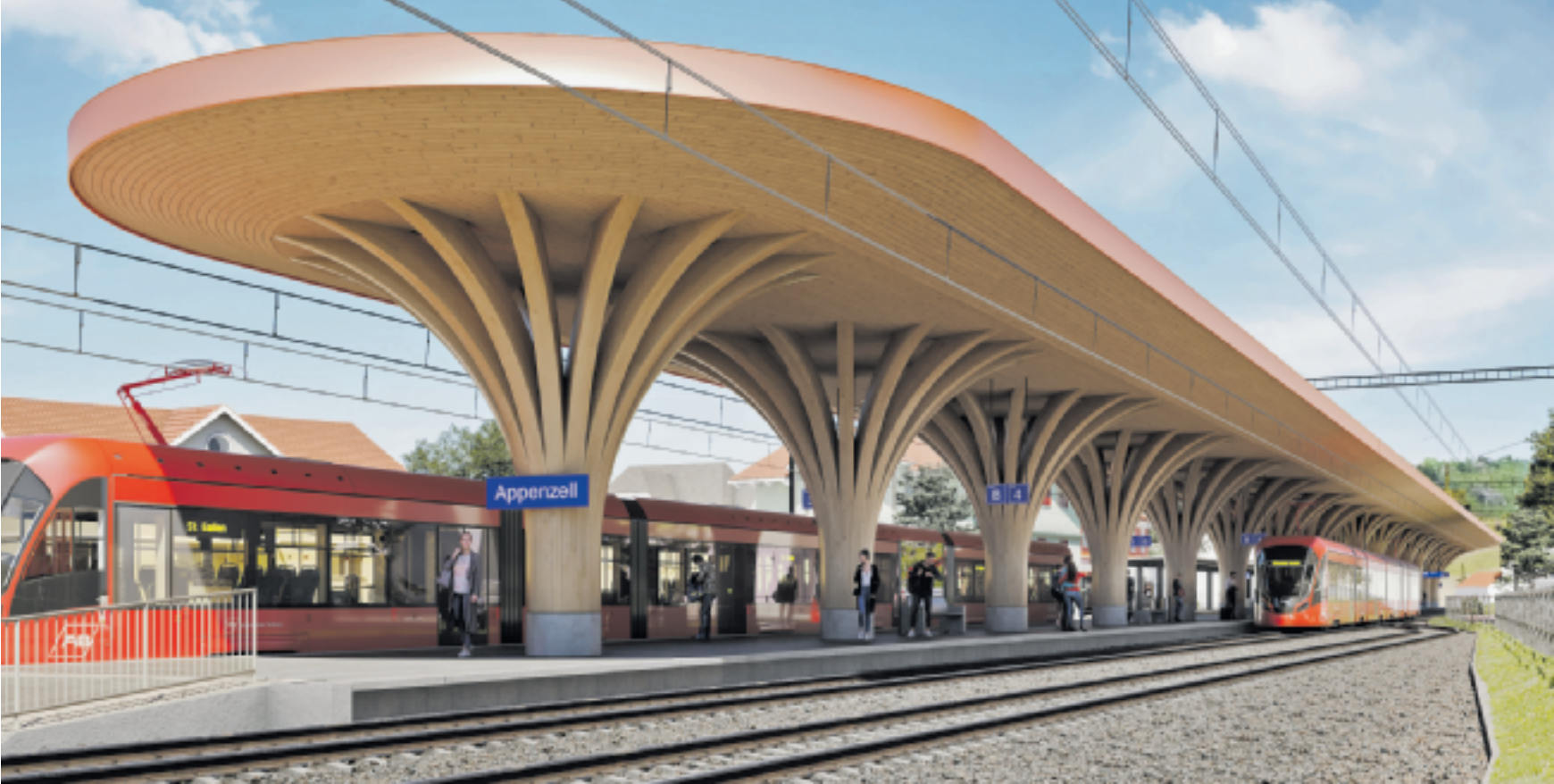
Die «Appenzeller Bahnen AG» wollen 2027 in Appenzell einen neuen, 175 Meter langen Mittelperron aus Holz realisieren, der einer Allee gleicht. Er ist mit fast 14 Metern Breite so auskragend, dass nicht nur Fahrgäste vor dem Wetter geschützt werden, sondern auch über Nacht abgestellte «Walzer»- und «Tango»-Züge. (Visualisierung: Appenzeller Bahnen / mfw architekten ag)
