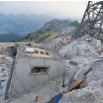
Drei der Betonfundamente sind bereits gegossen, für das vierte wird die Schalung erstellt.
